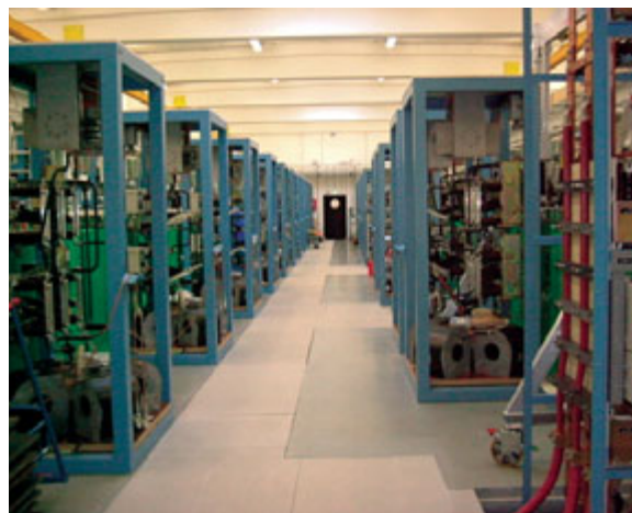
Abb. 1: Große Kondensatorbank am Hochfeldlabor am Forschungszentrum in Rossendorf (im Aufbau). Sie versorgt die Magnete mit der nötigen Energie. Um 100 T zu erreichen ist eine Energie von 50 MJ nötig.
